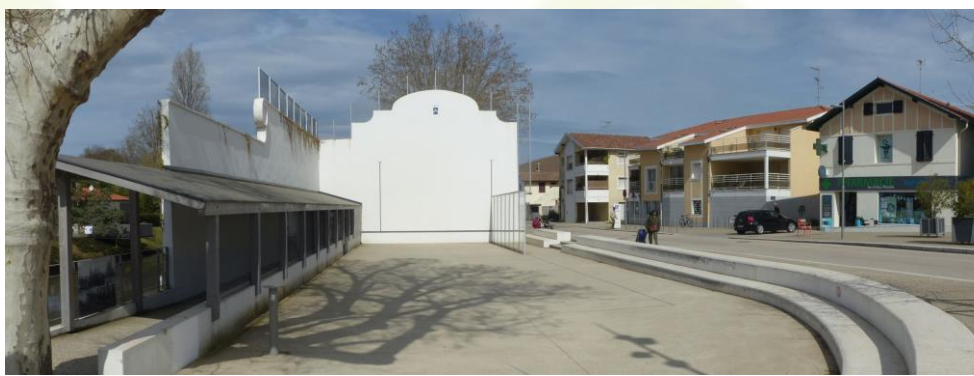
Capbreton, espaces publics réhabilités
