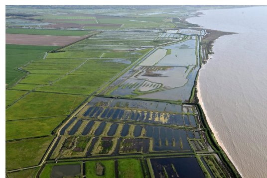
© GEOS-AEL – Vue aérienne de la brèche avril 2018
